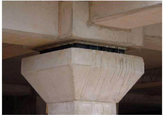
加固混凝土框架的隔音支承，10赫兹
